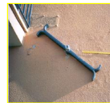
Presenza di catene metalliche
