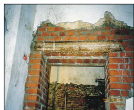
Apertura di nuove porte
