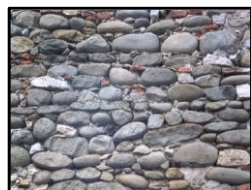
Muratura irregolare in pietrame di fiume
